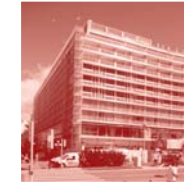
France Casinò Barrière, Nizza. Casino Barrière, Nice.
